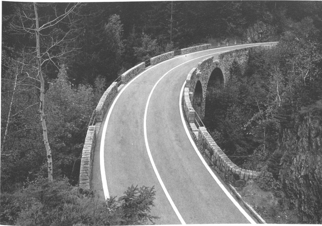
9. Sustenstrasse 1946; Abschnitt zwischen Chäppeli und Rossweidhubel, Nesselstal. IVS-Strecke BE 15.8. – Moderne, für den touristischen Automobil- ausflugsverkehr konzipierte Alpenstrasse mit durchgehendem Gestaltungskonzept. Mehrbogige Eisenbetonbrücke in einer Rechtskurve. Komplette Verblendung mit Granithausteinen, Brüstungsmauern alternierend mit Eisenröhrengeländer, vorstehende Wasserabflüsse.
