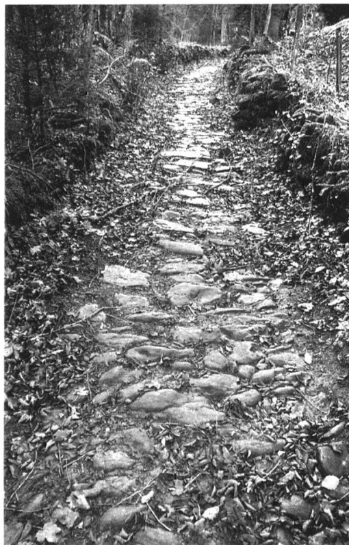
1 Bergweg vom Haslital ins Rosenlaut; Abschnitt oberhalb Zwirgi am Eingang zum Rosenlautal. IVS-Strecke BE 100.1.8. – Traditionelle Gasse mit Pflasterung. Beidseitige Stützmauern, teils freistehende Randmauern, aus grobblockigen Rundsteinen. Sowohl Erschliessungsweg zu den wenigen dauerbewohnten Höfen im vorderen Teil des Bergtales als auch Zügelweg der höher gelegenen Alpen und Saumweg zum Rosenlautibad und über die Grosse Scheidegg nach Grindelwald.
