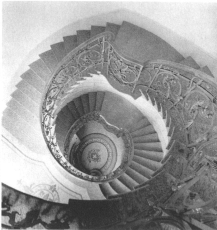
Eidgenössische Münzstätte, 1903–1906, nach Plänen von Theodor Gohl, restauriert und umgebaut 1990–1993, Treppenhau.
