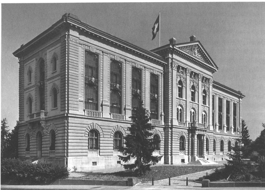
Bundesarchiv, 1894–1899, nach Plänen von Theodor Gohl, restauriert und erweitert 1982–1985.
