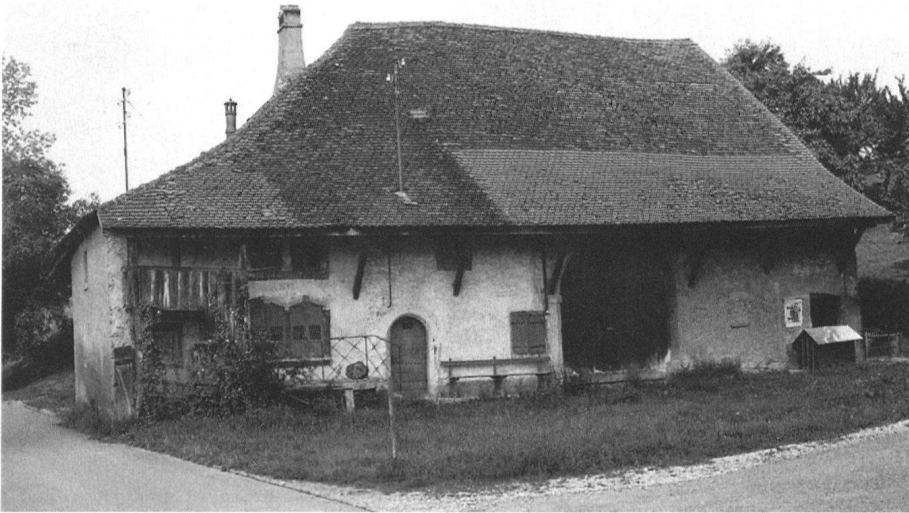
Châtillon FR, ferme double n° 14/15 avant la démolition, façade est du bâtiment n° 15. – A gauche, l'extension du bâtiment abrite un four; à droite, on observe une porte à linteau cintré en partie murée.
