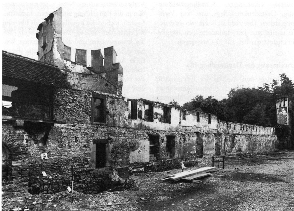
2 Basel, St. Alban-Tal, Webr- mauer mit Schalentürmen und dem bis auf Reste abgebroche- nen Wehrgang, stadtseitige Sicht vor der Restaurierung.
