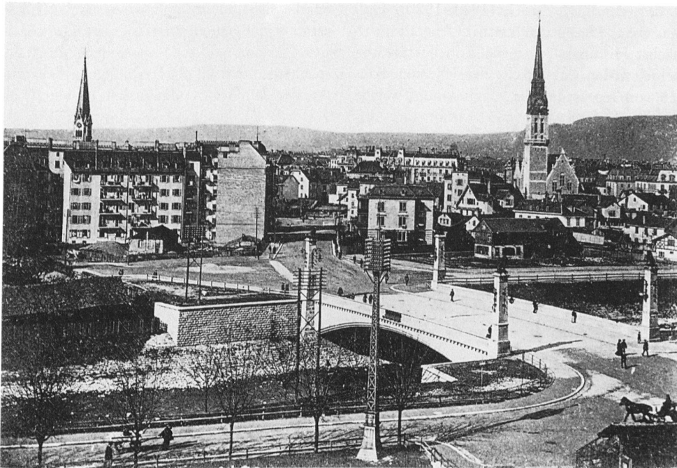
3 Zürich, Stauffacherbrücke. Blick von Süden, im Hintergrund links die Kirche St. Peter und Paul, rechts die St. Jakobs-Kirche. Die gewünschte grossstädtische Bebauung lässt auf sich warten. Postkarte um 1902.
