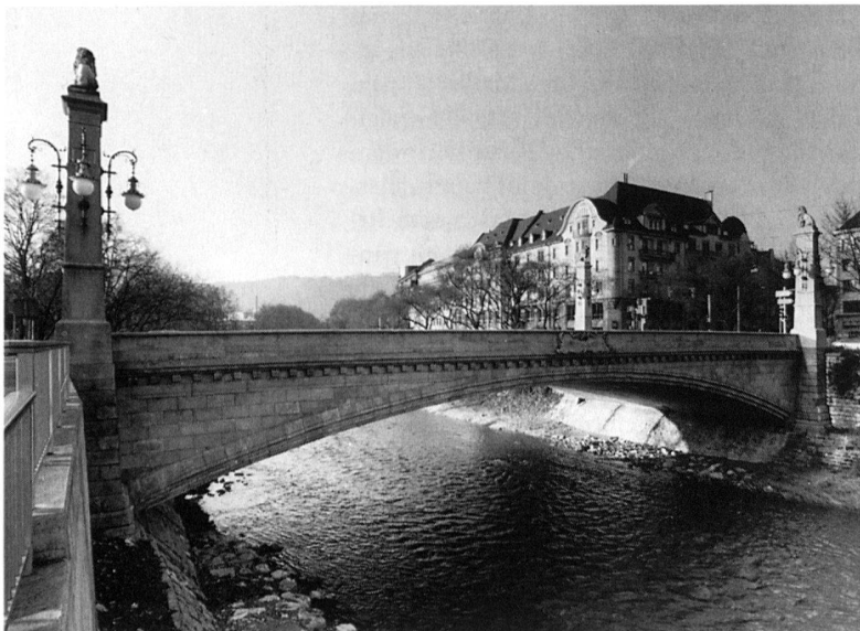
12 Zürich, Stauffacherbrücke. Nordostansicht nach der Sanierung, Zustand 1992.
