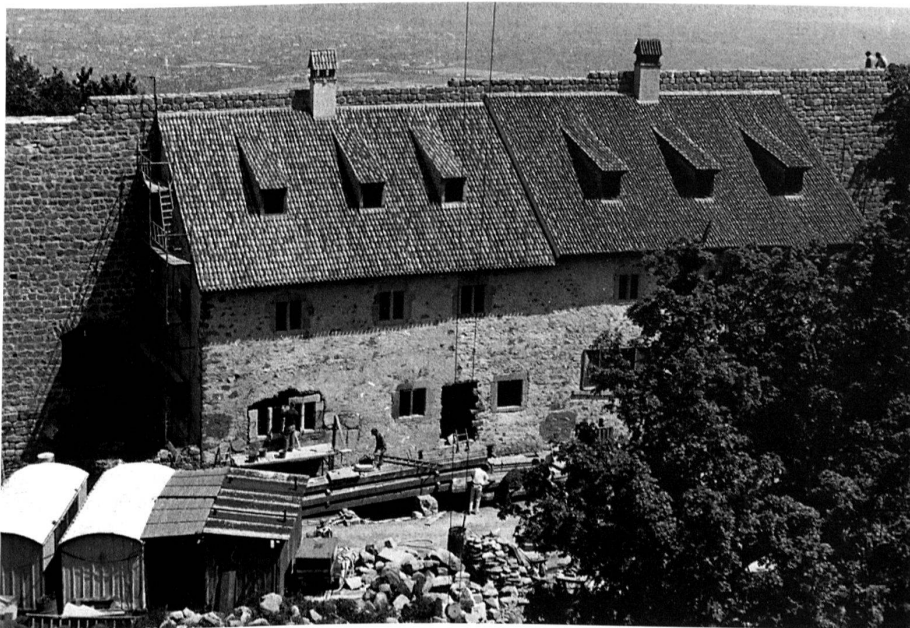
9 Vue d'ensemble des logis Schwendi et Lupfen adossés à la grande enceinte côté Est. A remarquer les toitures avec couvertures en tuiles canal, copies des modèles du XIII e siècle retrouvés en fouilles. Situation juillet 1995.
