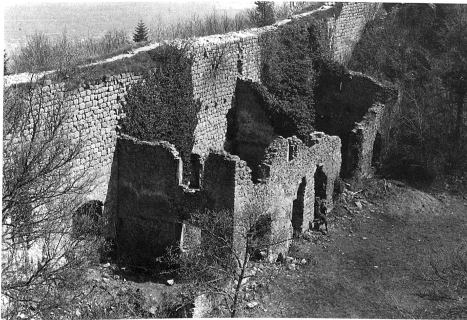
8 Vue d'ensemble des vestiges des logis Schwendi et Lupfen adossés à la courtine Est. Etat au début du chantier (février 1986).
