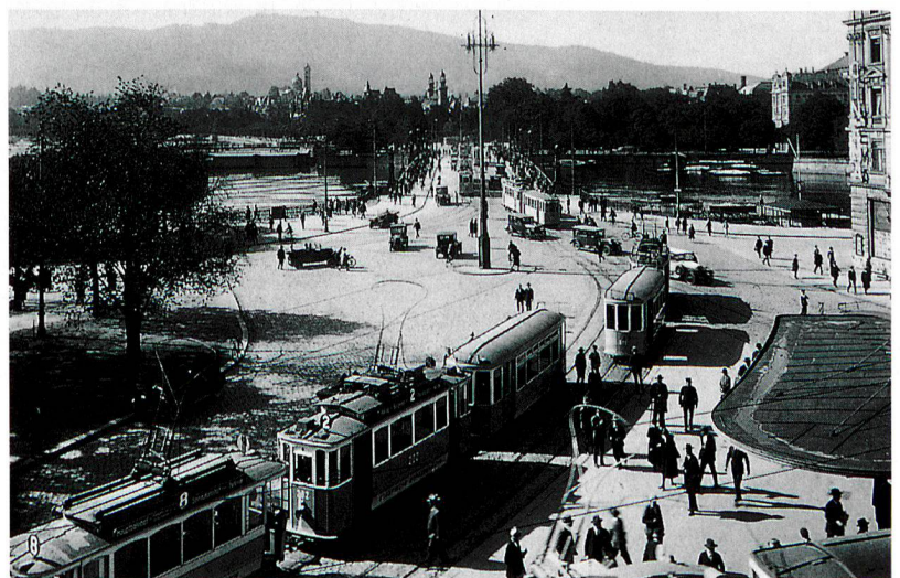
5 Zürich, Bellevue mit Blick Richtung Quaibrücke, 1926, Fotografie, Verkehrshaus Luzern. – Der schienengebundene städtische Nahverkehr ist voll ausgebildet, die Rolle des Automobils noch marginal. Keine Tafeln, Markierungen oder andere Verkehrsleitsysteme sind nötig.
