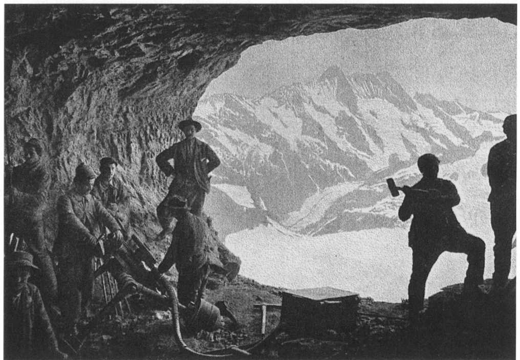
8 Arbeiter mit Hammer und Bohrmaschine beim Ausbruch der Station Eismeer, 1903.
