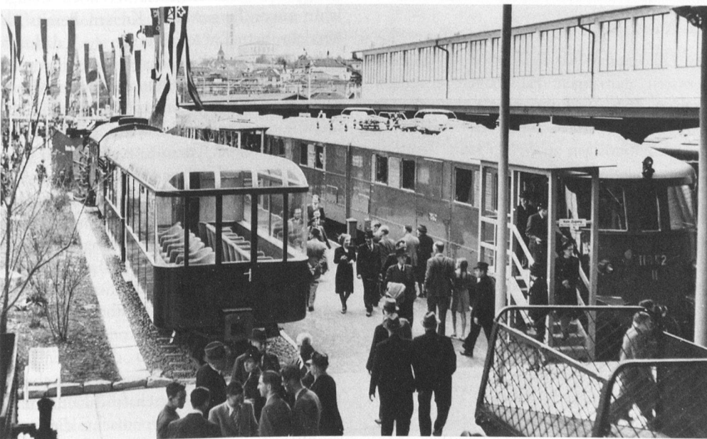
6 Das Freigelände der Abteilung Bahnverkehr der Schweizerischen Landesausstellung 1939 in Zürich. – Trotz der schlechten Lage am Ende des Ausstellungsgeländes waren die modernen Schienenfahrzeuge ein grosser Anziehungspunkt. Der Höhepunkt war die «Landi»-Lokomotive, die im Zeichen der aufkommenden Kriegsgefahr das Leistungsvermögen und die Unabhängigkeit der Schweiz symbolisierte.
