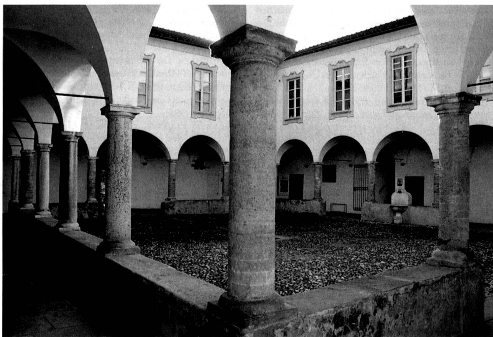
1 Mendrisio, ex Convento dei Serviti (XVII–XVIII sec.). Veduta del chiostro con il piano terreno porticato. La particolarità di questa costruzione sta nelle colonne: quasi tutte in cotto e poggiate su un muretto perimetrale.
