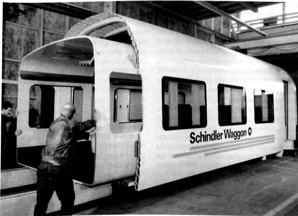
8 Schienenfahrzeug: Montage einer Innenausbau-Schale, 1994, Schindler Waggon AG, Altenrhein. – Einschiebbare Waggon-Innenausbauten für die Revitalisierung älterer Reisezugwagen sowie neue Wagenkasten werden in kürzester Zeit mittels eines Wickelverfahrens vollständig aus Faserverbundstoffen hergestellt.
