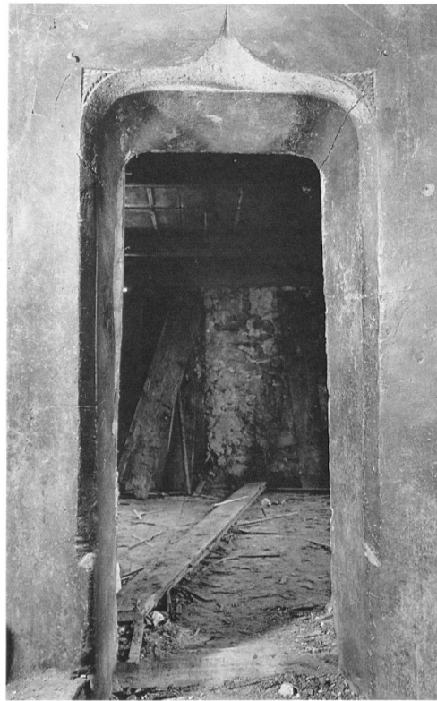
8 Maison privée, à Sion (rue de la Lombardie 8). Porte située dans la cage d'escalier (milieu du XVI e siècle).
