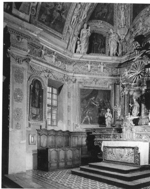
10 Olivone, Chiesa parrocchiale di San Martino, visione parziale delle pareti e della volta del coro (la fotografia è stata scattata prima dei lavori di restauro).
