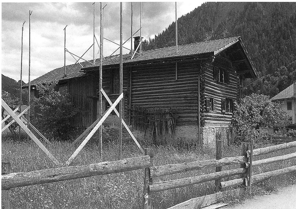
4 Die Ablehnung von Gebäuden, die dem Freilichtmuseum angeboten werden, bedeutet für diese meist die Zerstörung (Schiers-Schran, Kanton Graubünden).
