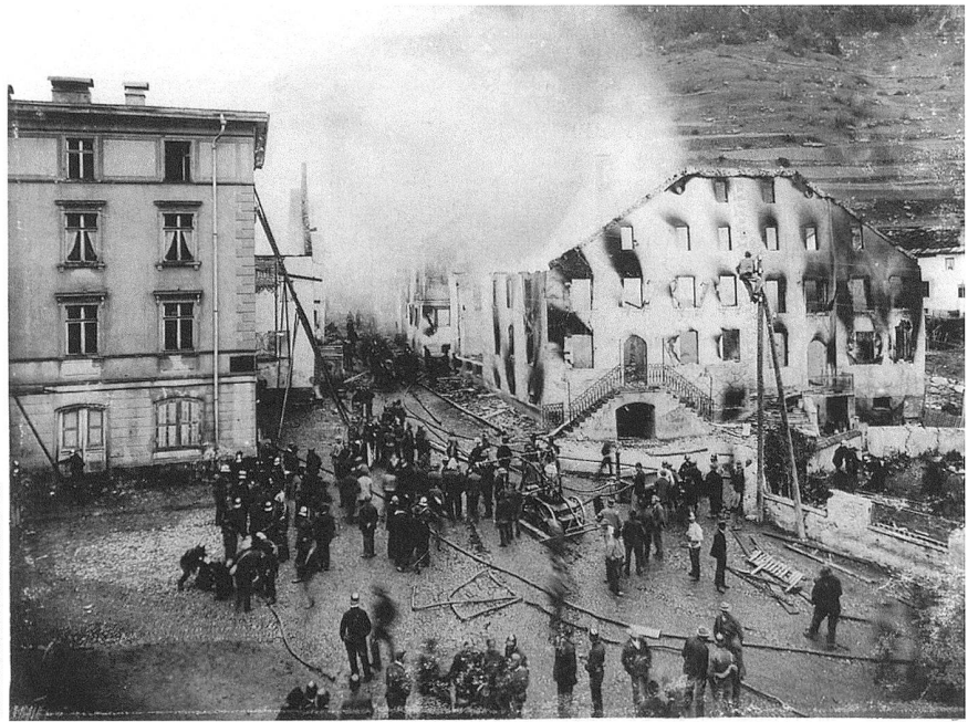
Dorfbrand in Susch vom 3. November 1900, bei dem entlang der Flüelastrasse 15 Häuser samt Ställe sowie die katholische Kirche vernichtet wurden.
