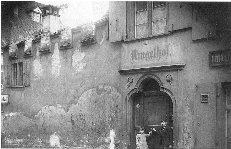
10 Basel, Ringelhof an der Petersgasse, Photographie um 1890. – Der zinnenbesetzte Hofabschluss entstand im Zusammenhang mit einer Neugestaltung des Wohnhauses durch den lombardischen Güterspediteur Cristoforo d'Annone im Jahr 1573.
