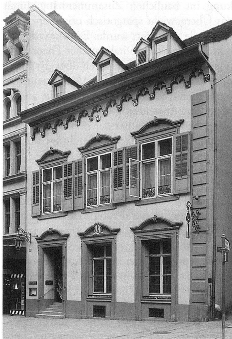
13 Basel, Zunftthaus zum Schlüssel an der Freien Strasse, Aufnahme von 1979. – Nach der barocken Umgestaltung des 1485/87 erbauten Hauses ist von der ehemals zinnenbesetzten Traufe nur noch der Masswerkfries übriggeblieben.
