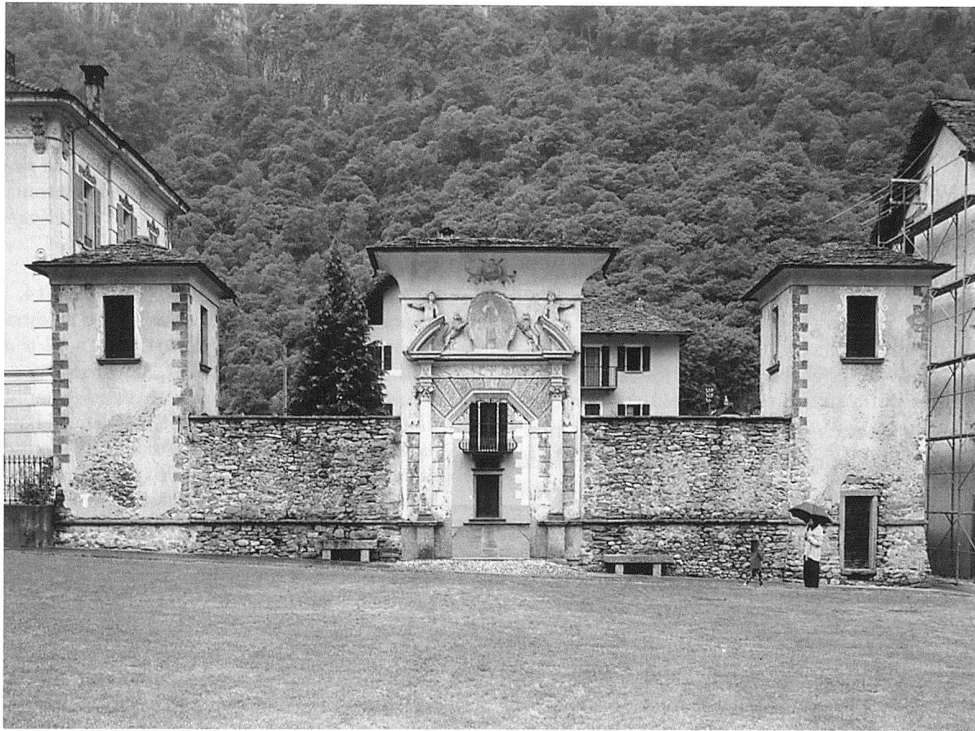
12 Cevio, casa Franzoni, veduta esterna della recinzione.
