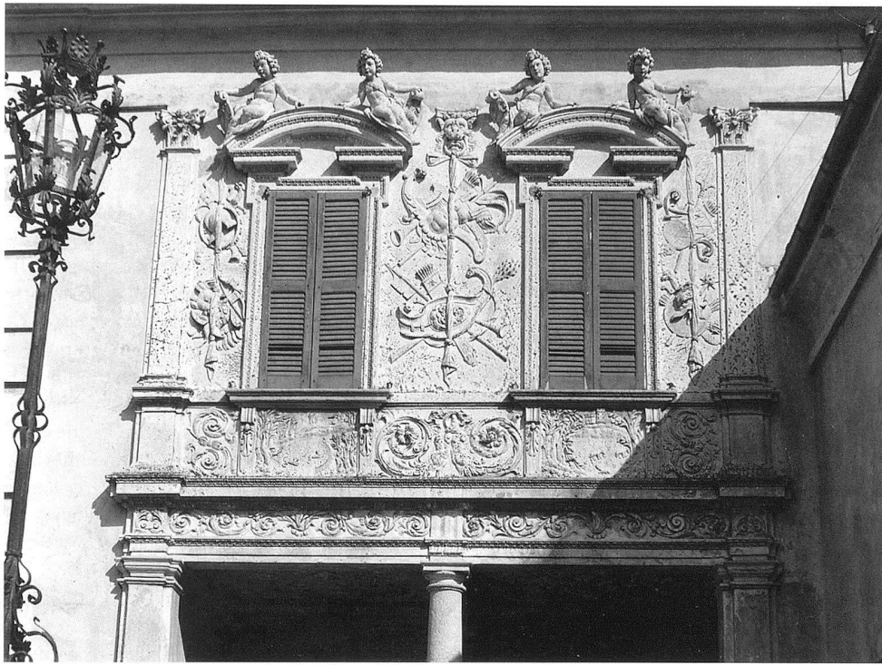
9 Locarno, Casorella, la loggia, 1615 ca.
