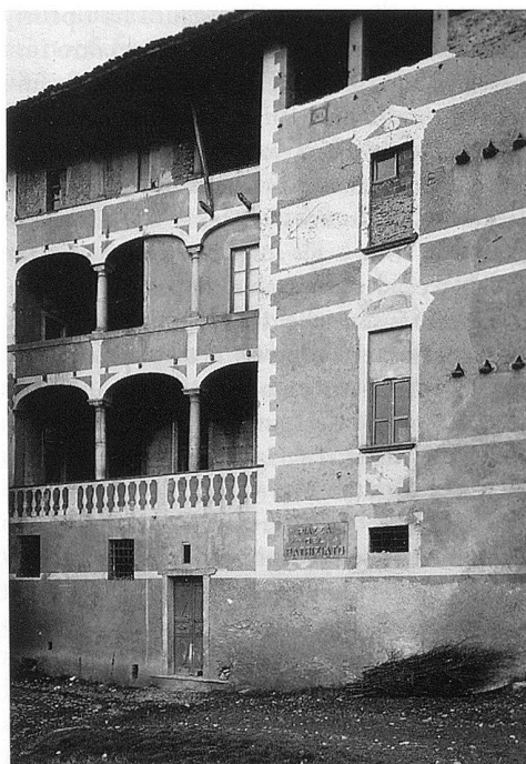
7 Carabbia, casa Ceruti, facciata meridionale. Fotografia anteriore ai restauri.
