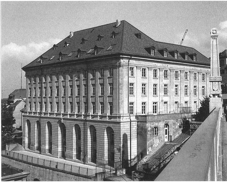
6 Lausanne, ehemaliger Grand Hôpital, Rodolphe de Crousaz, 1766–1777. – Mit der Kolossalordnung greifen Pilaster über mehrere Geschosse und betonen die Monumentalität des Spitals.
