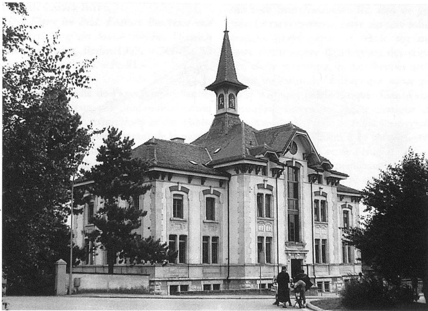
Collège de Champagne, 1900, par Bonjour et Dubois, architectes à Lausanne. Exemple caractéristique d'édifice «Heimatstil»: décor polychrome de pierre et de brique.
