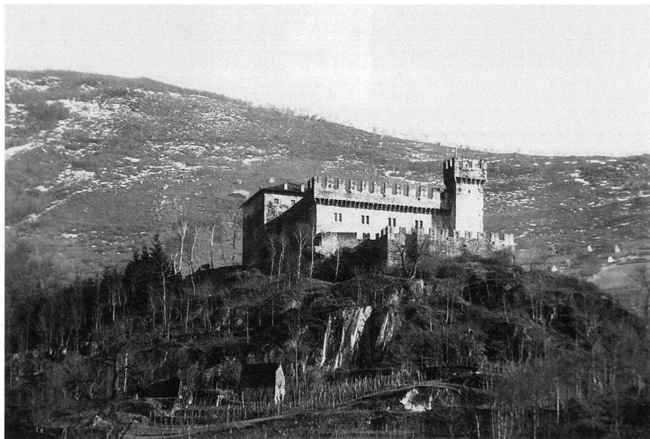
1 Bellinzona, castello di Sasso Corbaro, veduta dal basso, situazione 1900–1910 dopo i restauri.
