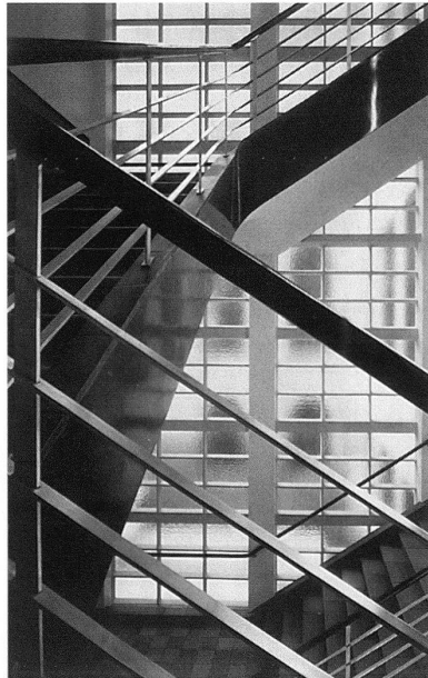
Otto R. Salvisberg, Maschinenlaboratorium und Fernheizkraftwerk der ETH Zürich, Treppenhäuser nach der Renovation. – Die originale Farbgebung wurde aufgefrischt, original sind auch die Bodenklinkerplatten und das Geländer.
