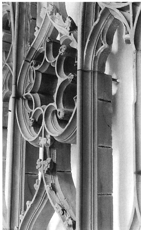
8 Basel, Kleiner Münsterkreuzgang, Euphrosynegrab, Detail. – Gut sichtbar sind die Nuten, in die zur Sicherung des Grabes einst eiserne Lamellen eingelassen waren.
