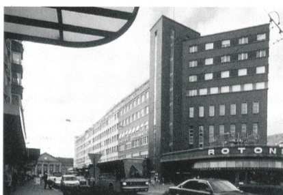
Biel, ehemaliges Volkshaus mit Bahnstrasse. (© Rolf A. Stähli, Winterthur)
