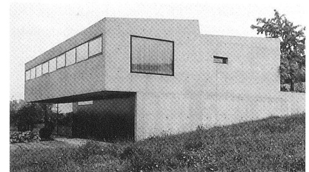
Einfamilienhaus in Bottighofen, 1996–97, Architekt Beat Consoni. (Repro, S. 75)
