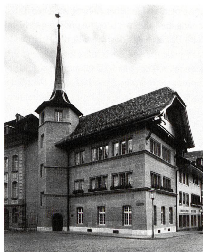
Zofingen, Zunfthaus zu Metzgern, 1603, Architekt Antoni Stab. (Kantonale Denkmalpflege Aargau)
