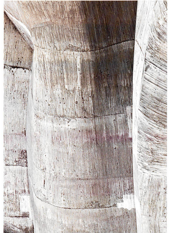
Betonplastik: Schalungsbild am Goetheanum
