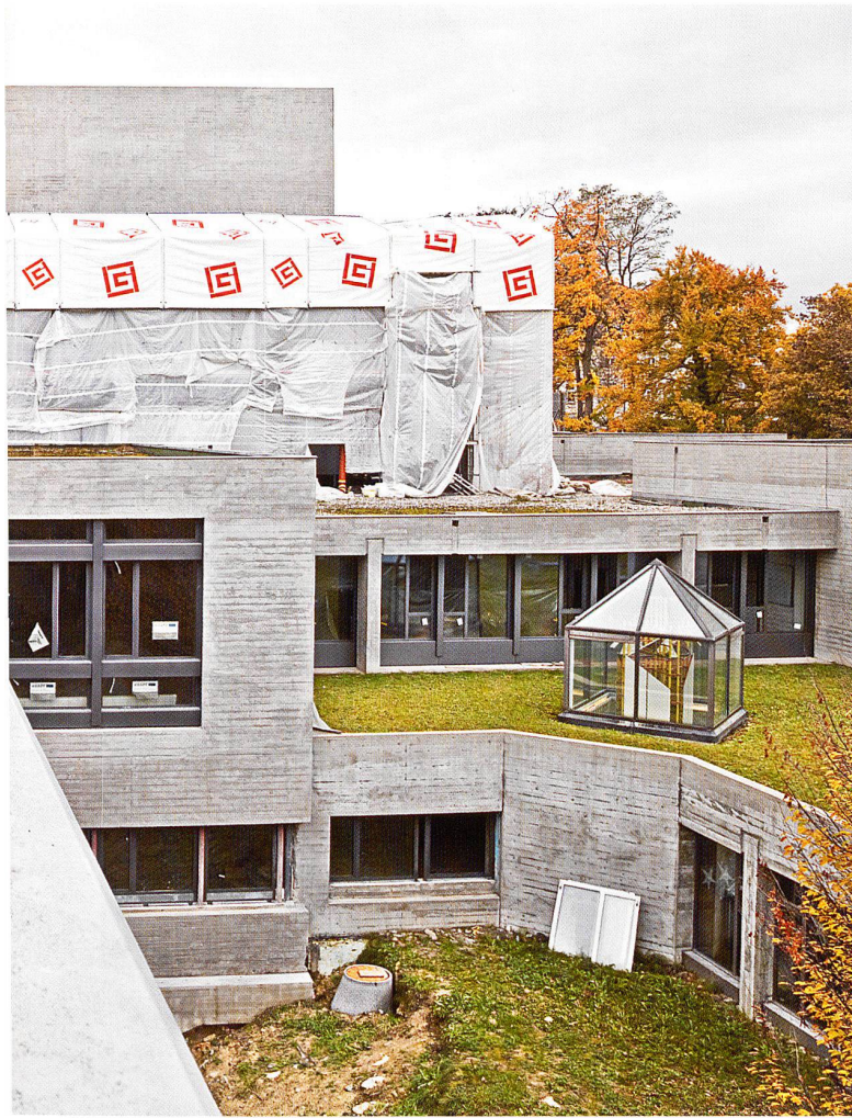
HSG St-Gall: bâtiment de Förderer avec la sculpture «Pièces infranchissables»
