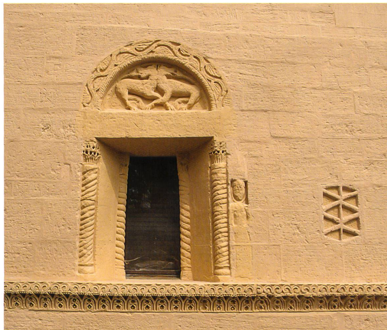
Fig. 16 Mise en valeur du décor par un jeu de deux tons d'ocre lors de la restauration de 2009 (photographie T. Châtelain, BPU/OPMSNE, 2011)
