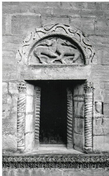
Fig.13 Détail de la fenêtre occidentale en 1915 et en 2004 (OPMSNE)
