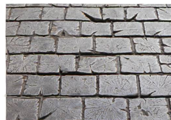
Fig. 5 Pavé en bois au 14, rue de l'Hôtel de Ville, datant probablement du milieu du XIX e siècle
