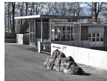
nach wie vor, ARA Jungholz Uster, 2011. Einen «schwitzenden Stein» kriert Katja Schenker für die Kläranlage in Uster. Die Künstlerin schafft einen Steinmonolith aus Blähton, aus dessen Oberfläche Wasser diffundiert. Fotos Claudia Bach
