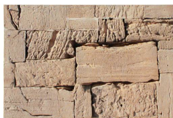
Fig. 16 Neuchâtel, rue des Poudrières 45. Pierre brochée et joints en ciment rubané. OPAN, 2009
