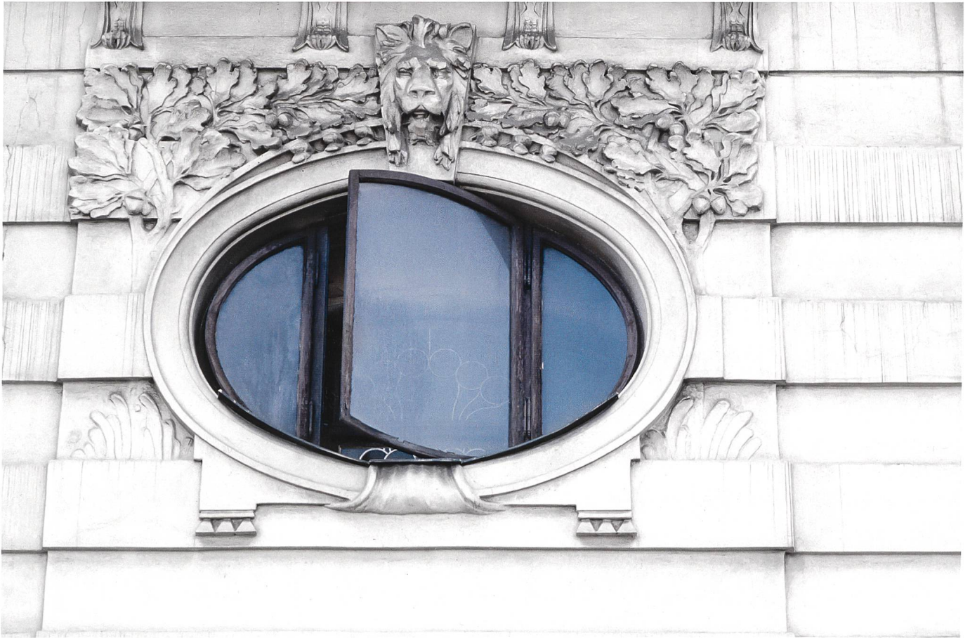
«Offene Fensterluke», Prag 1992
