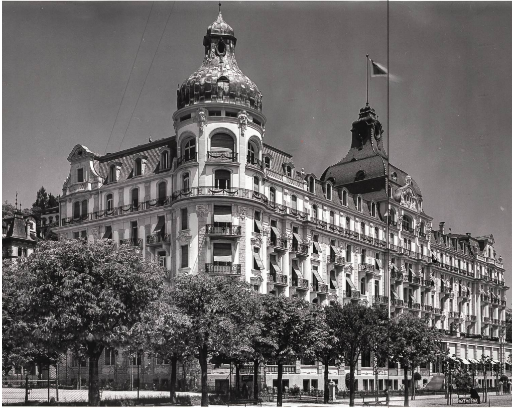
Luzern, Grand Hotel Palace, erbaut 1904–1906 von Heinrich Meili-Wapf. Erster Eisenbetonbau der Zentralschweiz, maskiert mit einer massigen Fassade zwischen Neubarock und Jugendstil. Foto Photoglob-Wehrli AG, kurz nach 1906
