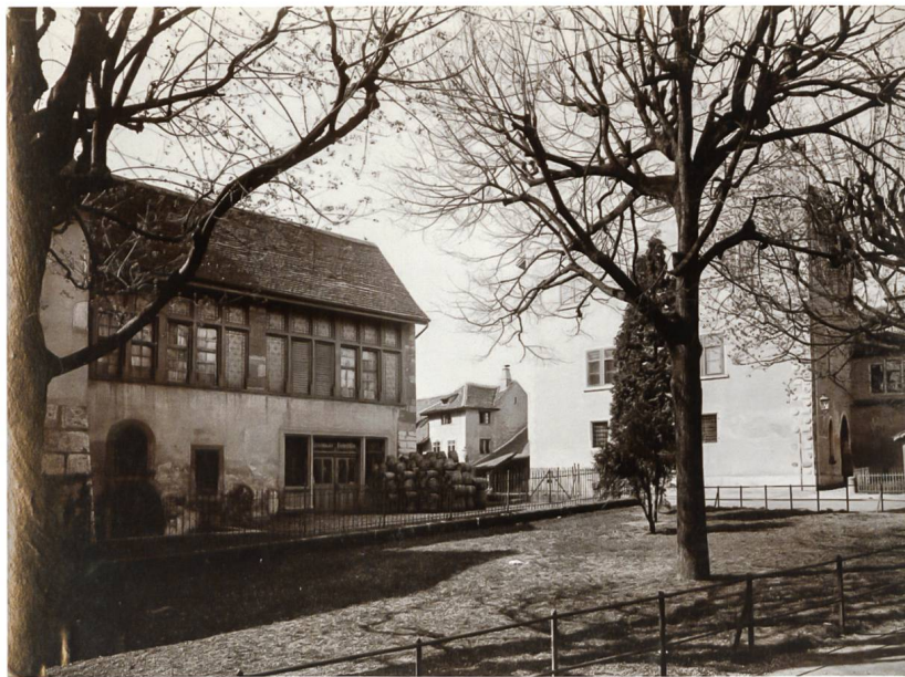
Abb. 3, 4 Ehem. Kloster Allerheiligen in Schaffhausen, Alte (jeweils links) und Neue Abtei (jeweils rechts) vor und nach dem Umbau zum Museum (1921–1928/1935–1938), Aufnahmen um 1920 (unten) und um 1938 (oben). Fotos: Stadtarchiv Schaffhausen
