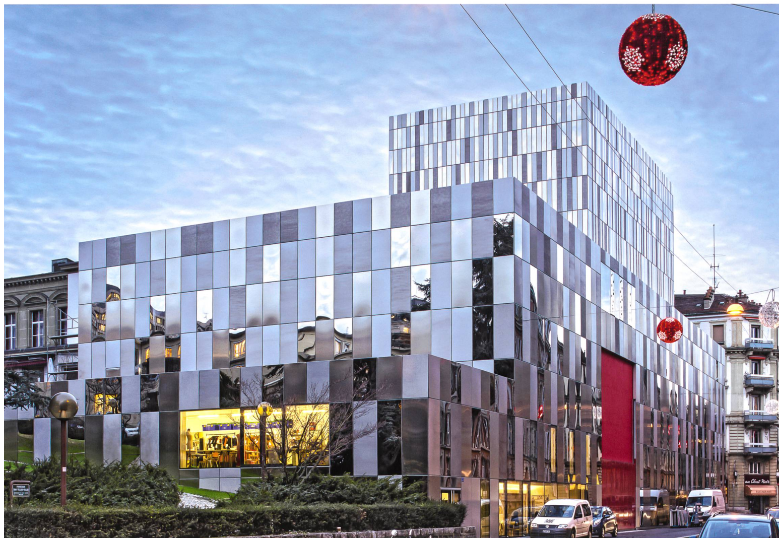
Opéra de Lausanne en 2012 ; vue du nouveau volume bas et de la nouvelle tour de scène depuis la rue Beau-Séjour (architectes : dl-a, Devanthery & Lamunière). Photo Adrien Barakat
