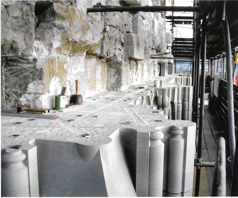
Der Austausch der äusseren Mauerschale am oberen Turmviereck West in den Jahren 1982–2002 war die letzte grosse Baukampagne vor dem Paradigmenwechsel. Mit der Massnahme ging u. a. eine Gerüststanddauer von ca. 20 Jahren einher (Foto im Jahr 2000). © Berner Münster-Stiftung
