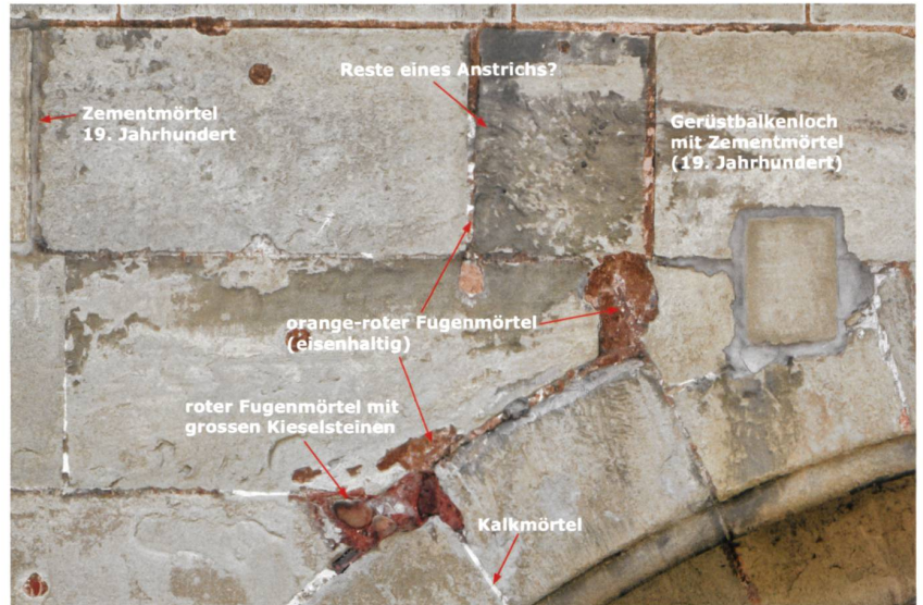
Von Ersatzmassnahmen verschont, ist das Obergadenfenster 90 an der Südseite des Chores eine bereichende Quelle der Baugeschichte. Der mittelalterliche Bestand zeigt Spuren verschiedener Restaurierungsphasen (unten: Gesamtansicht, oben: Detailausschnitt, 2016). © Berner Münster-Stiftung
