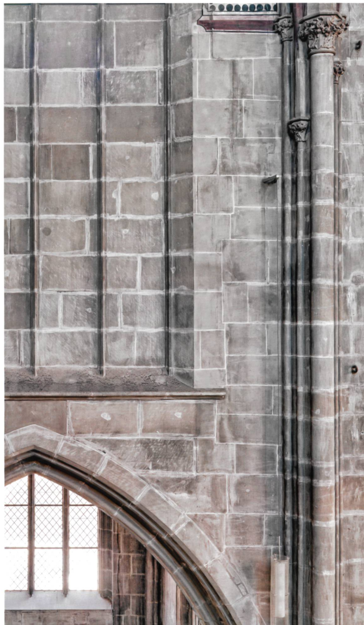
Abb. 2 Baunaht mit deutlichen Störungen im Mauergefüge, die weissen Fugen wurden später aufgemalt und entsprechen nicht überall dem originalen Fugenverlauf. Foto Nick Brändli / © Berner Münster-Stiftung
