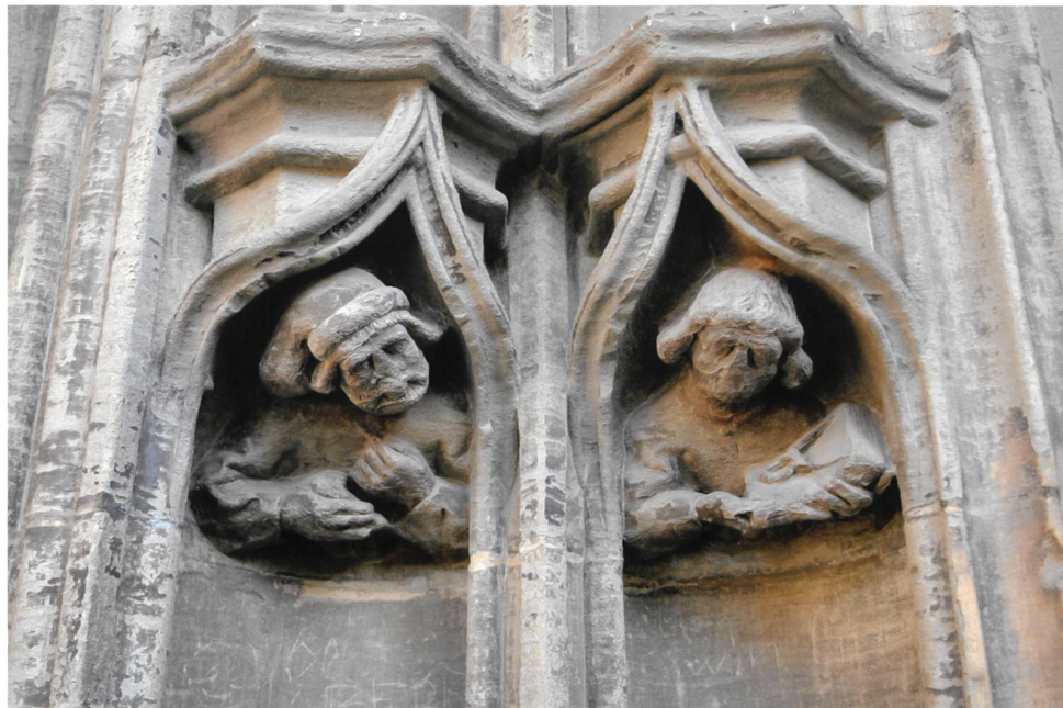
Abb. 10 Baumeisterkonsolen Südwestportal (Bern Münster, um 1460). Die beiden Werkmeister- bzw. Bildhauerkonsolen beziehen sich mit ihren Pendants auf die vier gekrönten Märtyrer der Steinhauer (Quattro Coronati), wie sie auch im Chorgewölbe am Triumphbogen erscheinen. Sie stehen für die hohe Wertschätzung der Werkmeister, wobei die Steinmetzzunft (Affen) möglicherweise als Stifterin auftrat. Rechts ist ein Mitglied der Ensinger Familie (Matthäus oder Vinzenz) dargestellt. Foto Bernd Nicolai
