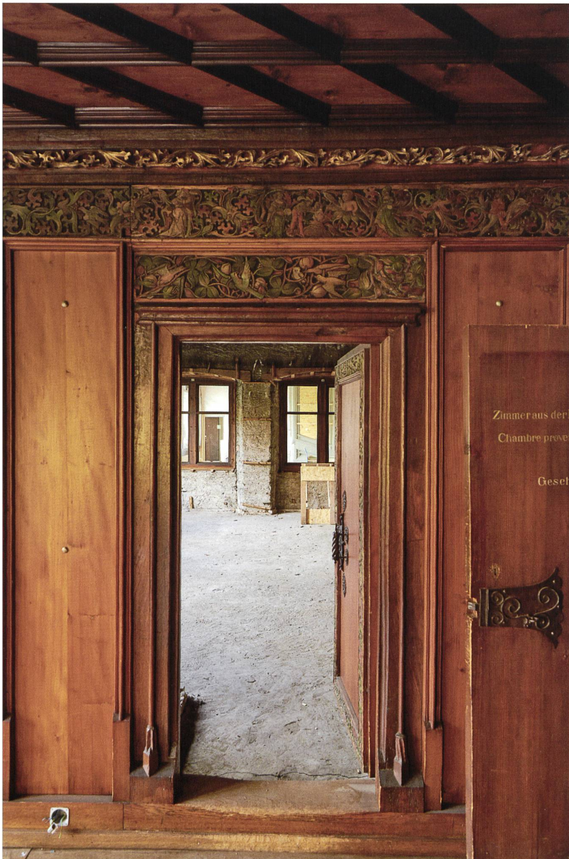
Äbtissinnenstuben im Landesmuseum Zürich während der Sanierung des Westflügels, Blick aus der kleinen in die grosse Stube mit dahinter- liegender «Loggia», Baustelle im November 2016. Schweizerisches Nationalmuseum
