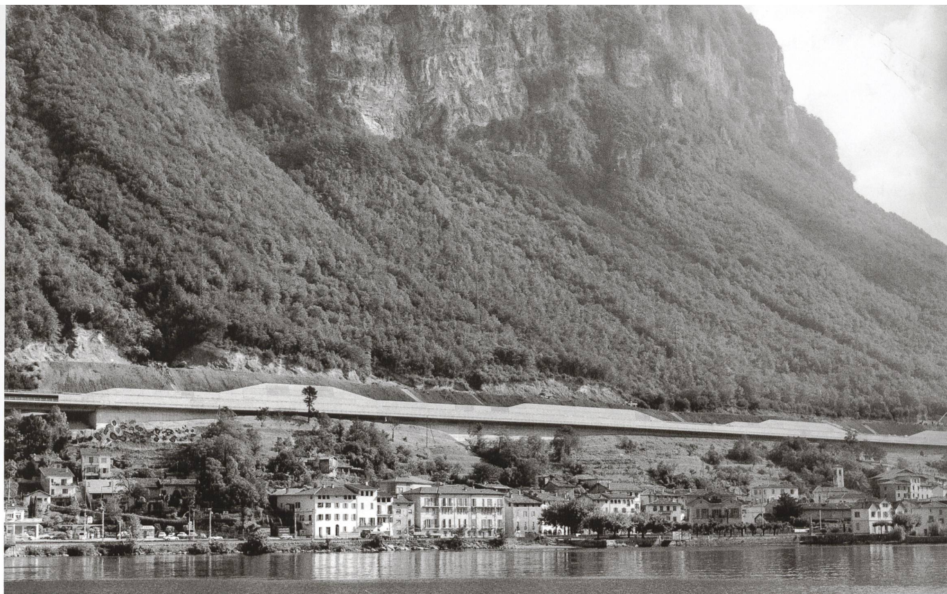
Muri di sostegno del tratto autostradale sopra Capolago. Archivio del Moderno. Fondo Rino Tami
