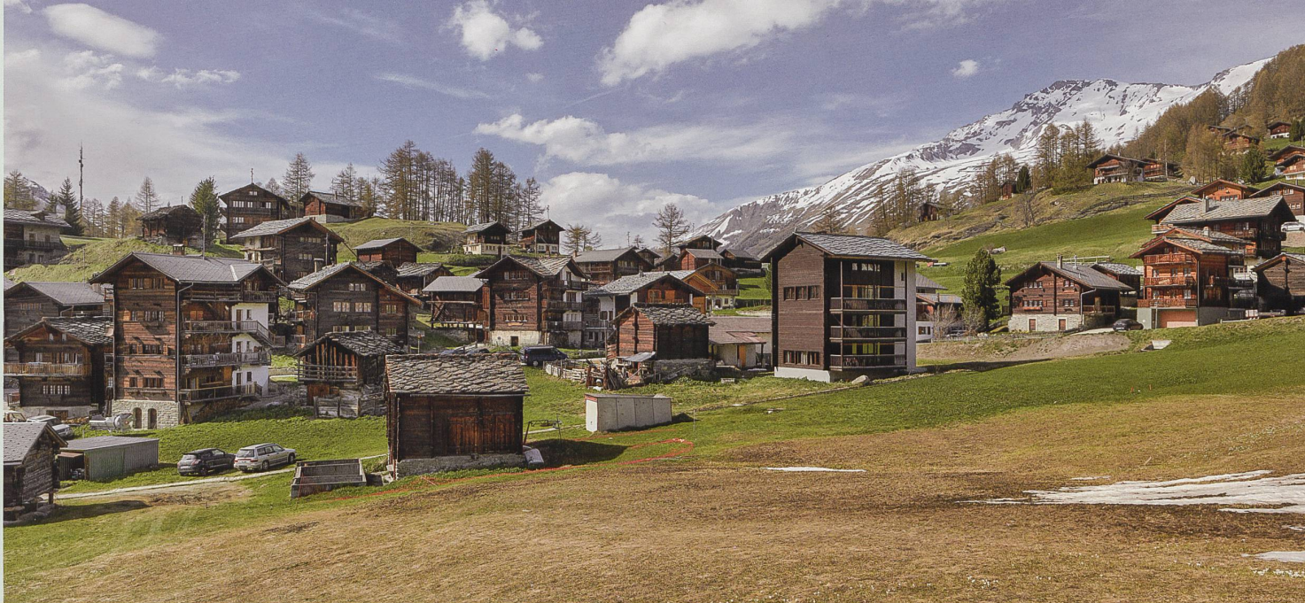
Fig. 2 Faces sud-ouest et sud-est. Le chalet, situé à la jonction entre le village historique sur la gauche et les « nouveaux » chalets isolés des années 1970-1980, sur la droite, dans les hauteurs, agit comme un trait d'union. © Dirk Weiss, 2018
