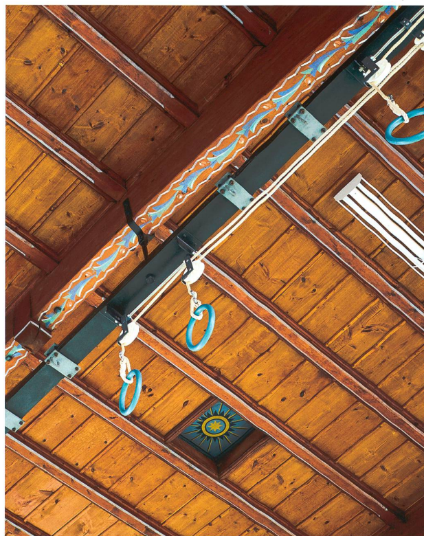
Die mit Dekorationsmalereien geschmückte Holzdecke der Turnhalle in Holderbank wurde nach dem «System Hetzer» konstruiert. Carl Froelich erbaute die als Mehrzwecksaal konzipierte Turnhalle 1924/25. Foto Dirk Weiss
