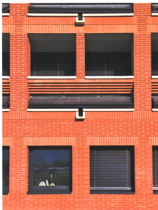
Dettaglio del fronte sud dell'edificio Sasso Rosso. Al piano terra le finestre degli uffici, ai piani superiori le logge binate dei dormitori con i pannelli fotovoltaici integrati nel parapetto. Foto Silvia Berselli
