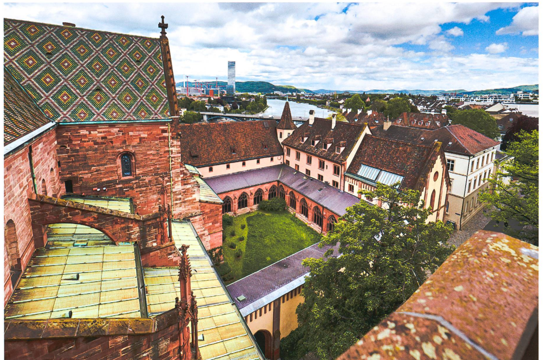
Nebenbauten und Doppelkreuzgang Blick vom unteren Teil des Martinsturms nach Südosten über den Grossen Kreuzgang und die Nebenbauten – Münstersaal, Bischofshof und Maria-Magdalena-Kapelle (v.l.n.r.). Foto Dirk Weiss, 2019
