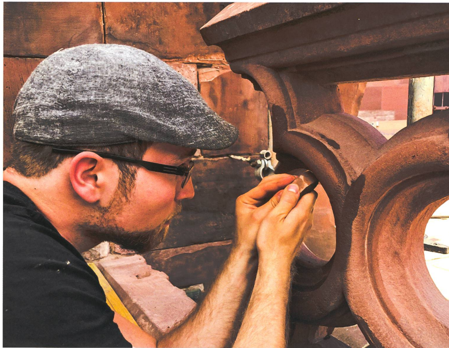
Chorbaustelle. Steinmetz Nicolai Hellstern überarbeitet eine durch Antragung von Steinerfüllungsmörtel erfolgte Reprofilierung an der Masswerkbrüstung. Foto Basler Münsterbauhütte
