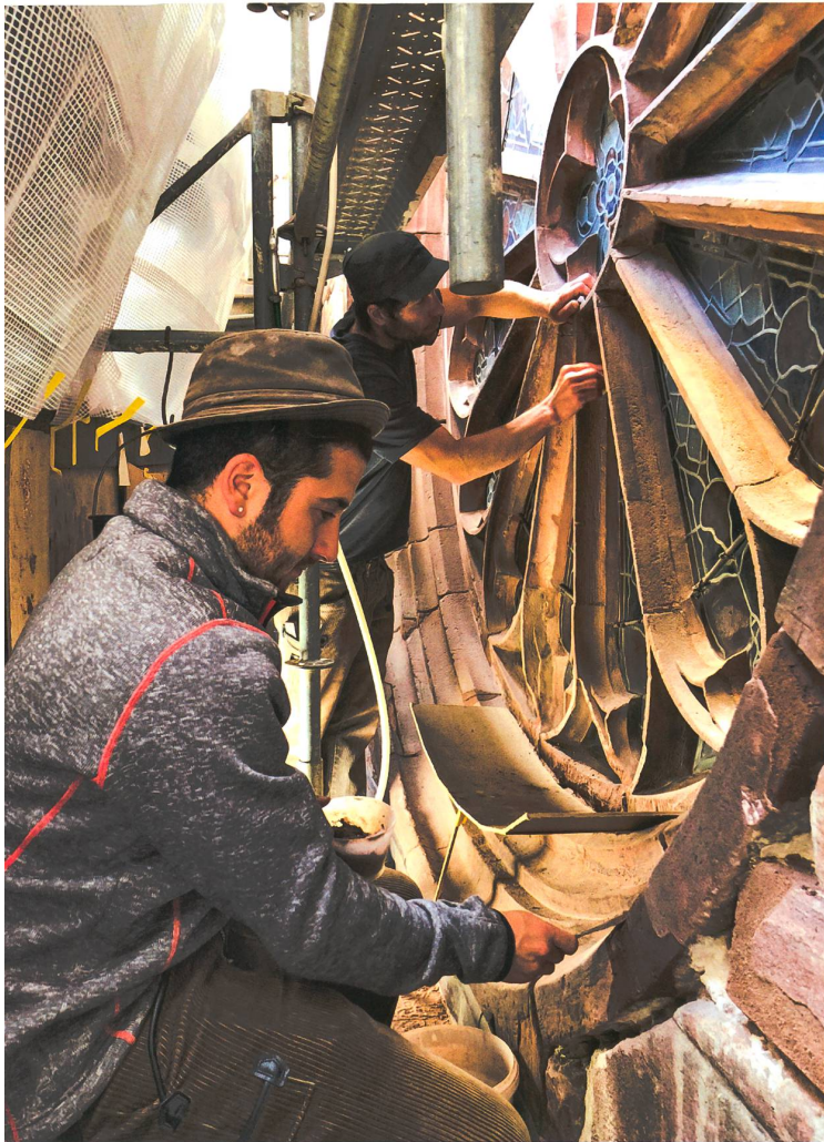
Chorbaustelle. Steinhauer Jérôme Lorenz während Antragsungen in Steinerergänzungsmörtel. Foto Basler Münsterbauhütte
