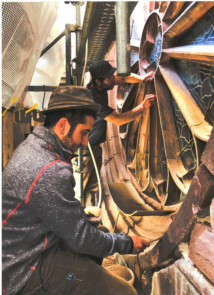
Chorbaustelle. Steinhauer Jérôme Lorenz während Antrags in Steinerergänzungsmörtel. Foto Basler Münsterbauhütte
