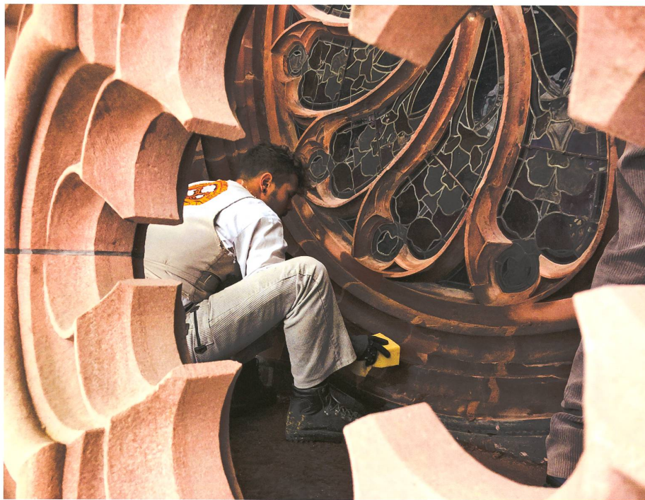
Werkstatt St. Alban-Tal 43. Steinbildhauer Oliver Senn bei der Anfertigung einer neuen Kopie der Masswerkbrüstung am Chorpolygon. Foto Basler Münsterbauhütte
