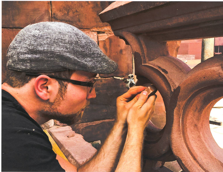
Chorbaustelle. Steinmetz Nicolai Hellstern überarbeitet eine durch Antragung von Steingänzungsmörtel erfolgte Reprofilierung an der Masswerkbrüstung. Foto Basler Münsterbauhütte
