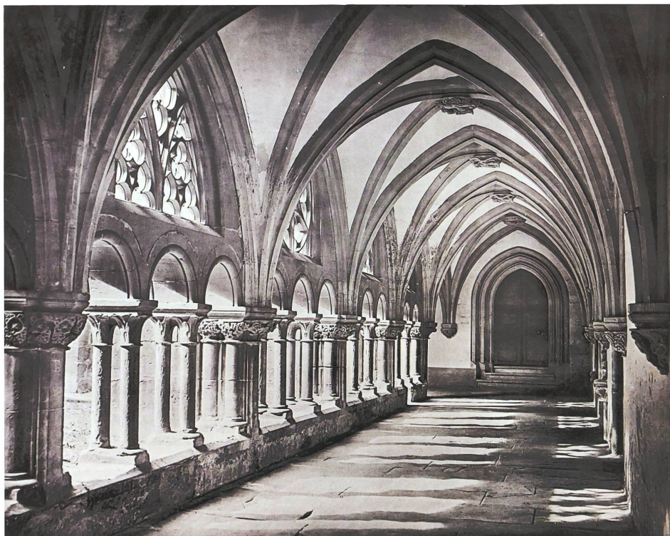
Abb. 7 Die Fotografie des Ostflügels des hochgotischen Kreuzgangs der Zisterzienserabtei Hauterive wurde publiziert als Planche XVIII in Fribourg artistique à travers les âges . 1890
