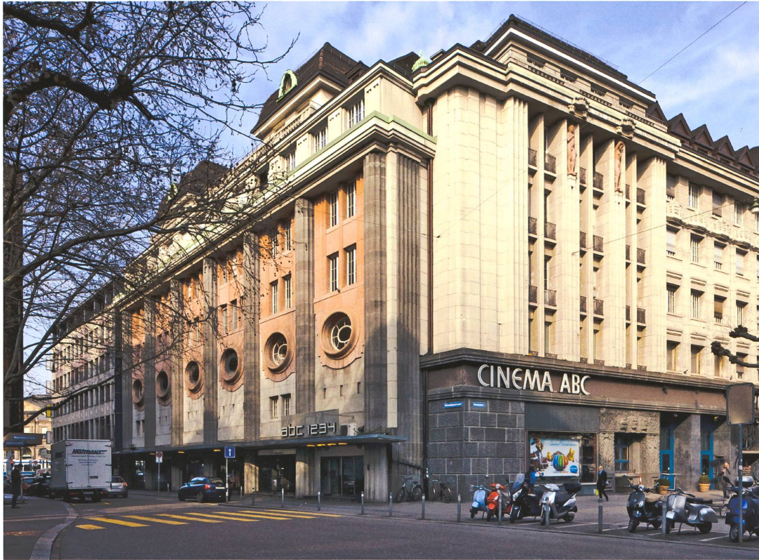
«Du Pont»-Gebäude mit ehemaligem Kino «Orient» am Beatenplatz, ovale Oculifenster als Kinomotiv, 1913. Foto Juliet Haller, BAZ, 2011
