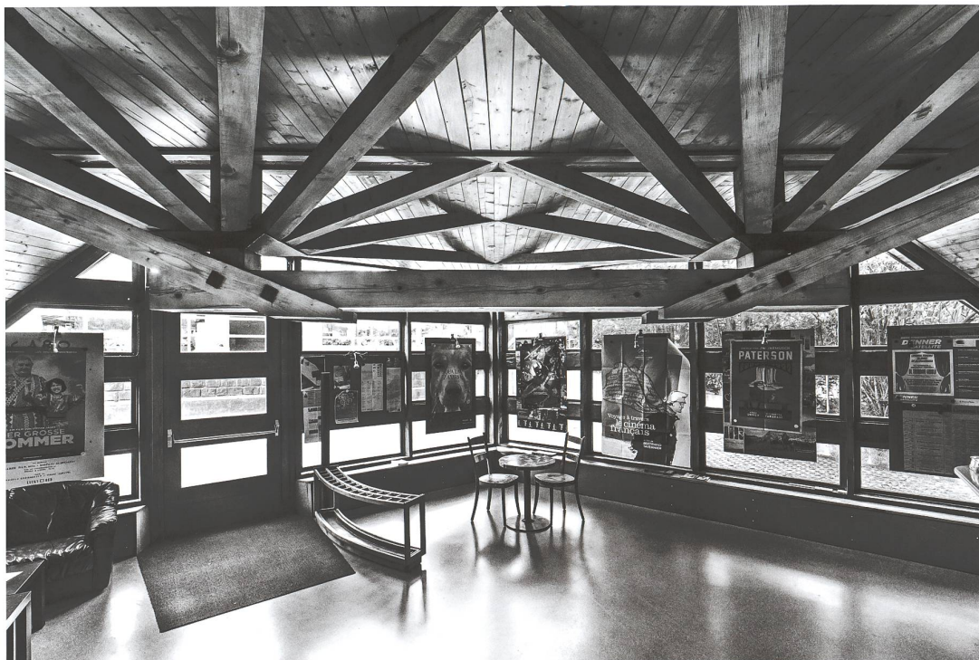
Fig. 8 Le capriate rovesciate del foyer d'entrata dell'edificio. © Ph. Roberto Conte, Milano
