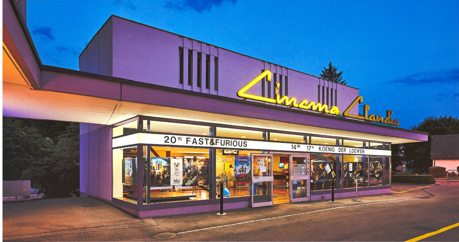
Abb. 10 Kloten, Kino «Claudia», erbaut 1961–1963 nach den Plänen des lokal ansässigen Architekten Hans Müller. Das nur über ein Vordach mit einem Wohn- und Geschäftshaus verbundene Kino setzt einen wichtigen städtebaulichen Akzent. Foto Dirk Weiss 2019
