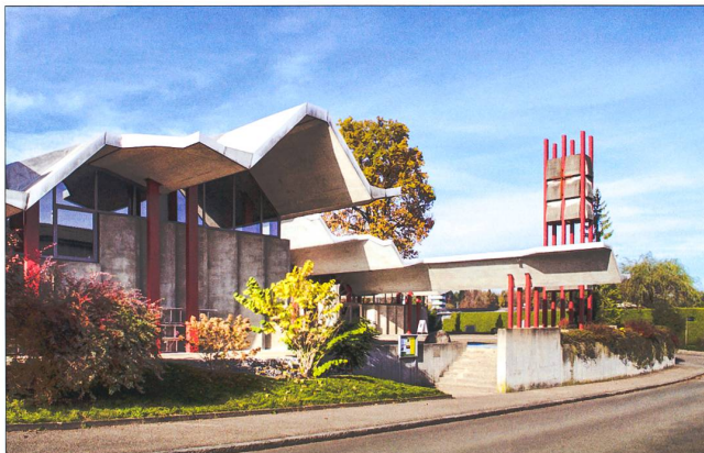
Architekturbibliothek.ch Pfarrkirche Bruder Klaus Ansicht Süd Adresse: Hinter-Listrig, Emmenbrücke, LU Architektur: Zempfer, Hans, 1966 – 1972 Foto: Claudio von Eaw, 2017, Hochschule Luzern – Technik & Architektur
